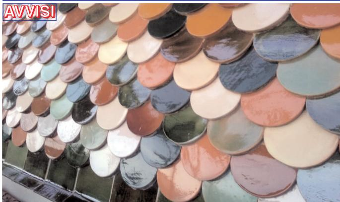
**\* INIZIATA LA FASE CONCLUSIVA DEI LAVORI DEL RESTAURO ESTERNO DELLA CUPOLA!** Infatti la scorsa settimana, dopo il montaggio delle finestrelle della lanterna, è iniziato il posizionamento del manto di copertura finale costituito dalle tegole in ceramica. La foto qui a fianco, che ci è stata gentilmente concessa dall'impresa esecutrice dei lavori, mostra il dettaglio delle prime file delle tegole già posizionate.
